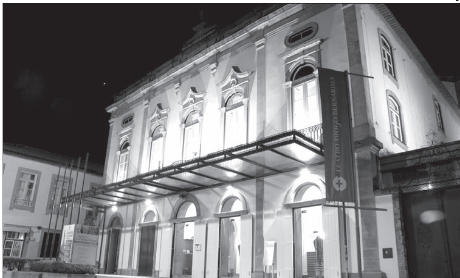
Teatro Diogo Bernardes, em Ponte de Lima
