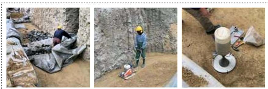
Figura 12 – Ligação dos drenos transversais ao dreno longitudinal. Compactação e ensaios no aterro controlado (setembro de 2006)
