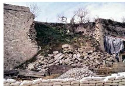
Figura 3 – Segunda derrocada da muralha de Chaves (2004)
