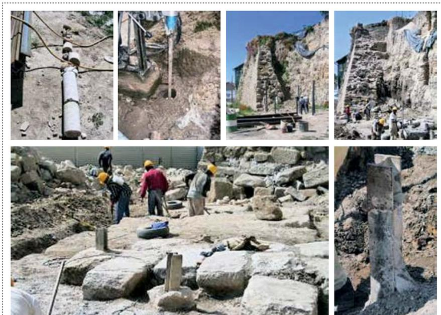
Figura 10 – Preparação para a execução do *jet-grouting* e arranque da fundação da muralha (julho de 2006)
