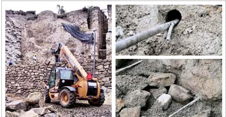
Figura 7 – Pormenores da ligação do novo pano de muralha ao existente: varões selados com grout (setembro de 2006)
