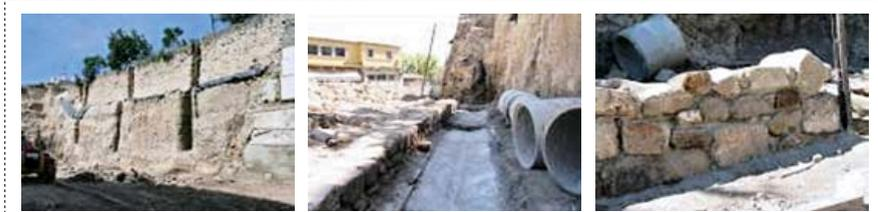
Figura 11 – Execução das drenagens transversais e paralelas à muralha. Pormenor do arranque do paramento da muralha (agosto de 2006)
