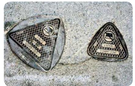
Figura 2 – Tampas de esgoto de Reuleaux. Sem risco de acidente!
