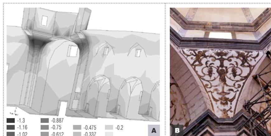
Figura 5 – Dano de compressão no interior da igreja, na zona do cruzeiro: (a) tensões principais de compressão e (b) fissuração observada nas trompas e nascenças dos arcos do cruzeiro
