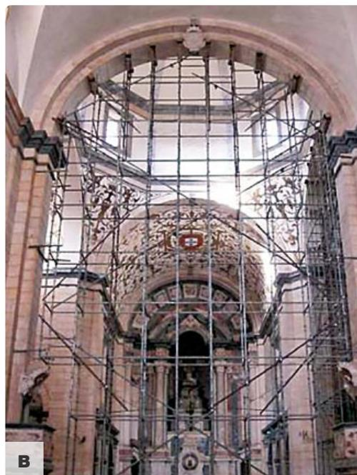
Figura 1 – Panteão dos Duques de Bragança: (a) vista geral e (b) estrutura de escoramento de um dos arcos do cruzeiro, com uma altura no fecho de 16,0 m
