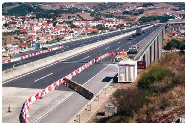
Figura 2 – Substituição de juntas de dilatação no Viaduto de Loures – A9 CREL
