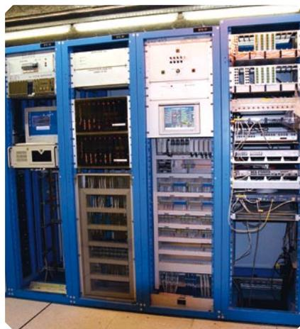
industrial. Pelo facto destas subestações permitirem o acesso permanente, o CERN decidiu que as mesmas dispõem de uma interface humana-máquina, o que permite que operadores autorizados possam supervisionar e controlar localmente os processos da subestação. As URTs colocadas em edifícios de superfície podem abranger várias subestações, pelo que algumas são muito grandes em termos de sinais e medidas adquiridos, que espelham as condições reais da subestação.
